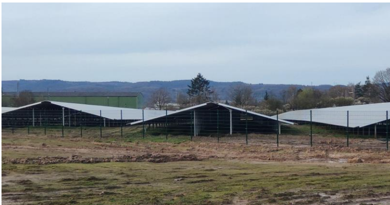
Abb. 2 Süd-Ansicht einer Ost-West-Anlage mit geringen Reihenabständen
