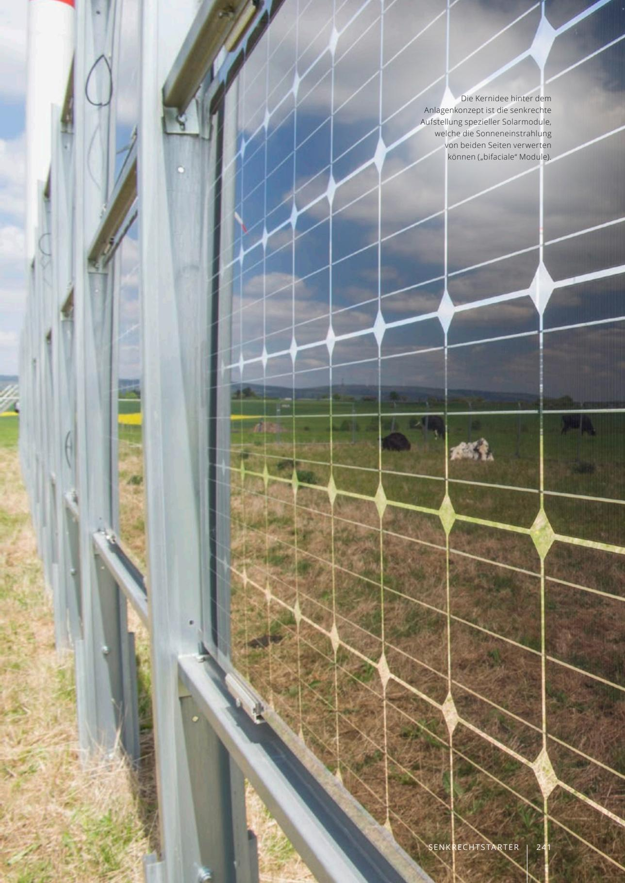
Die Kernidee hinter dem Anlagenkonzept ist die senkrechte Aufstellung spezieller Solarmodule, welche die Sonneneinstrahlung von beiden Seiten verwerten können („bifaciale“ Module).
